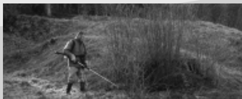
Travaux de débroussaillage
