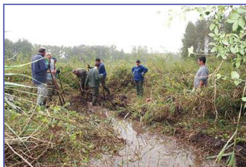
Travaux sur la roselière de Bulcy
