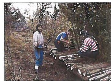
Notre équipe de chantier met en place le sentier de découverte
