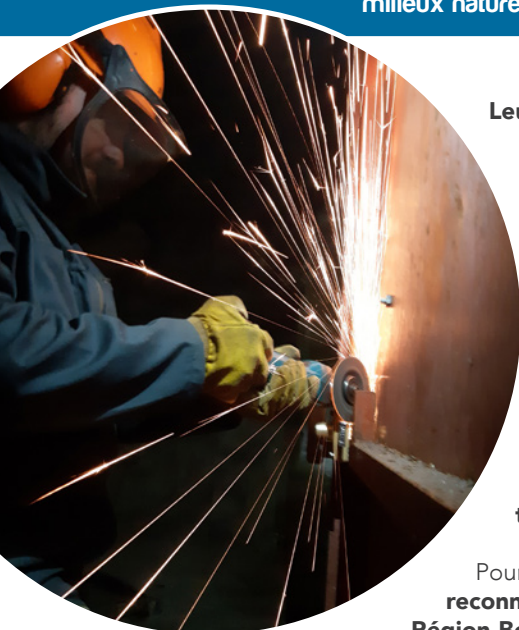
Travaux de fermeture de cavités à chauves-souris G. Aubert - CEN Bourgogne
