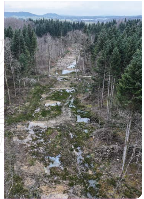
Vue en drone du ruisseau du Bois des Fallets après travaux
