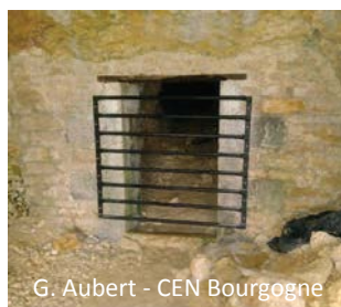
G. Aubert - CEN Bourgogne Grille de protection posée sur une entrée de carrière
